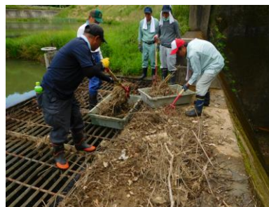
堆積ゴミ撤去作業
